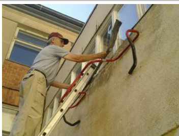
Helppo räystäslautojen as.
