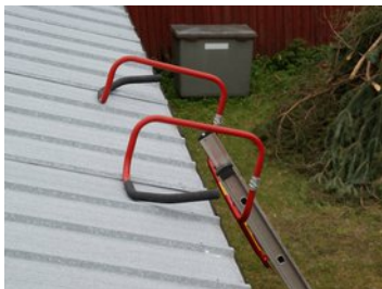
Ei vaurioita rännejä
