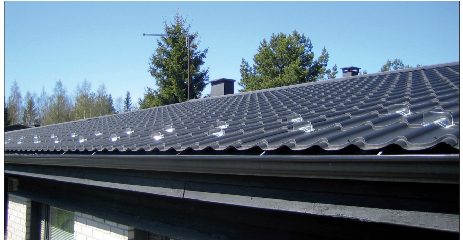
Kulo lumieste on materiaalsi ansiosta katolla lähes näkymätön. Lumiesteet jakavat lumi-kuorman painon tasaisesti koko katolle.
